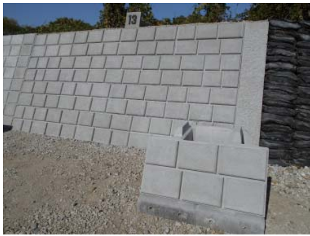
護岸ブロック敷設（正面）
