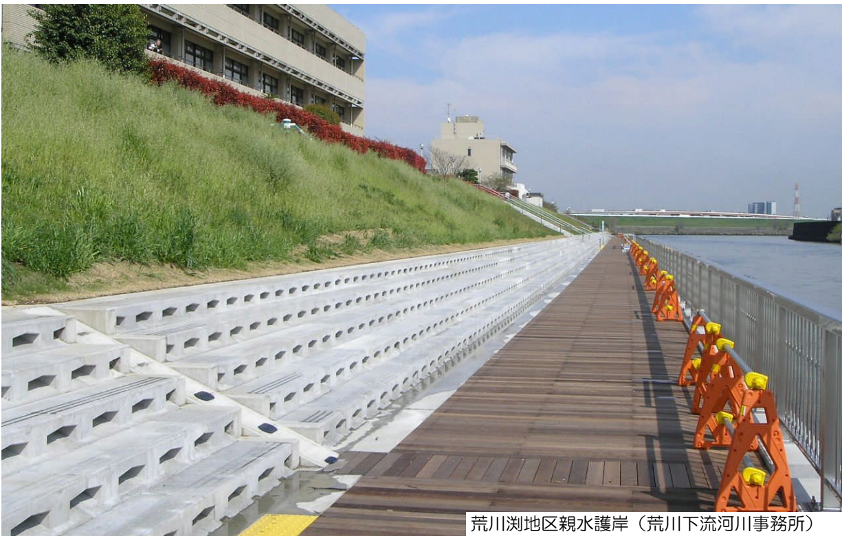
荒川渚地区親水護岸（荒川下流河川事務所）
