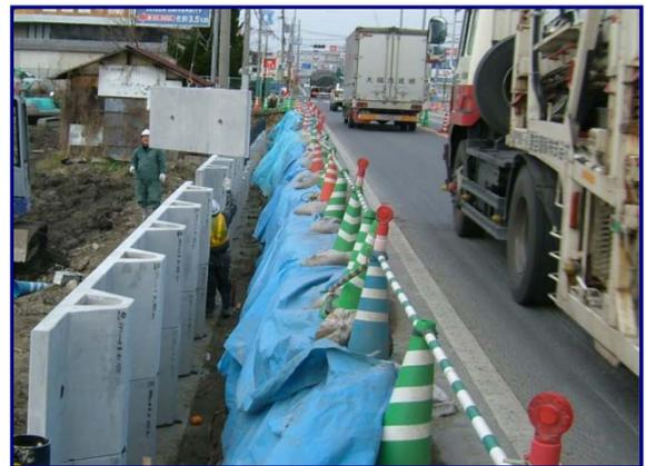
掘削幅が少ないので交通量の多い現場でも通行止めすることなく施工可能。
