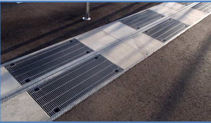
安養寺入町線補助道路整備工事
