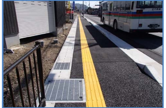
第54号市道上田西本郷線側溝改修工事(2工区)
