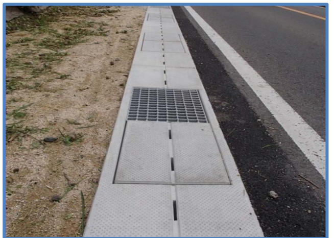
滋賀県発注 道路維持補修
