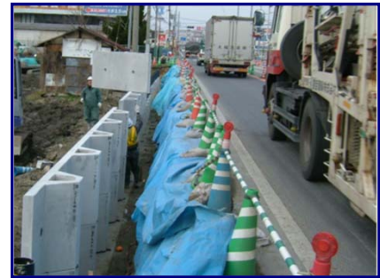
掘削幅が少ないので交通量の多い現場でも通行止めすることなく施工可能。
